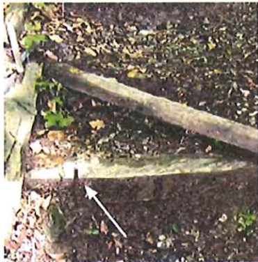
Ferro di armatura sporgente
