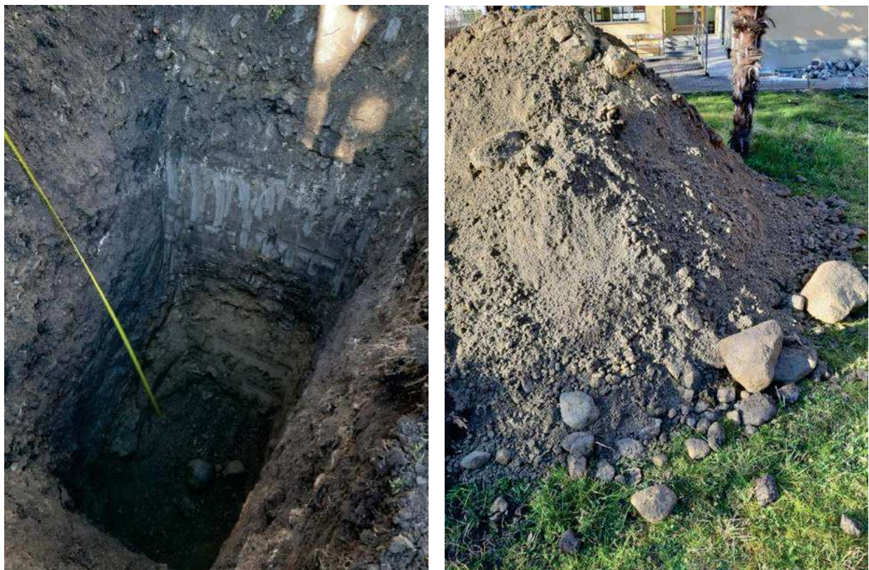
Fig. 11 – Scavo geognostico eseguito a est dell’edificio e terreno presente al di sotto dei -2 m.
