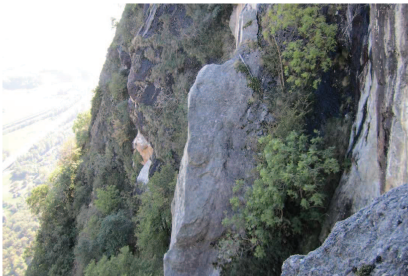
Fig.16 Voluminoso diedro distaccato dalla parete rocciosa con riempimento della frattura e presenza di vegetazione, sostenuto ovviamente da un possibile ponte in roccia
