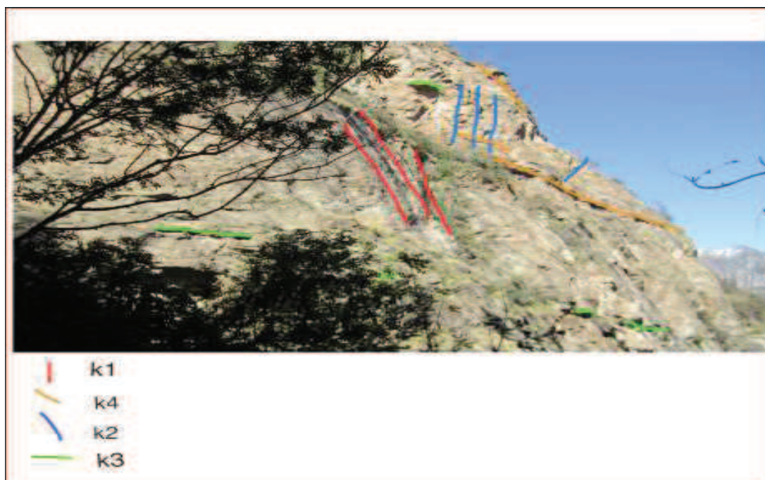
Fig.17 foto presa ad una certa distanza dall'area interessata dai crolli mostra chiaramente tutti i sistemi di discontinuità presenti sul fronte roccioso prospiciente la destra orografica
