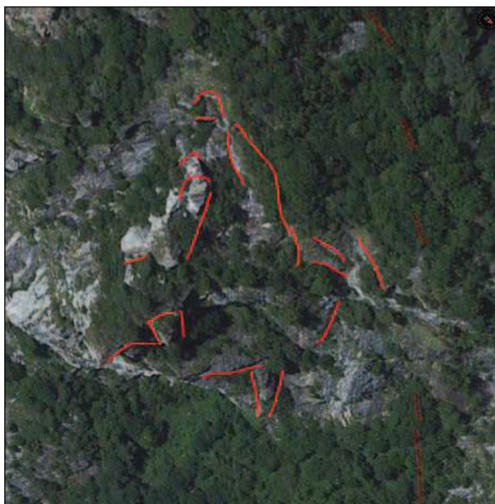
Fig. 6 Situazione della grossa fratturazione dell'ammasso roccioso che incombe nella parte alta
