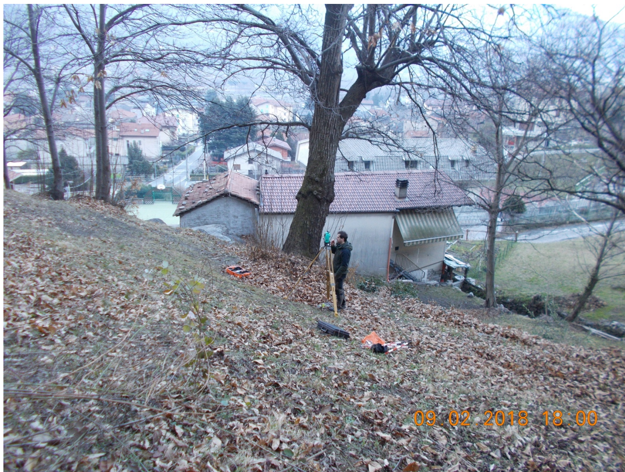
Foto 35: Vista verso la sezione 28 – Tracciato scarico tubazione
