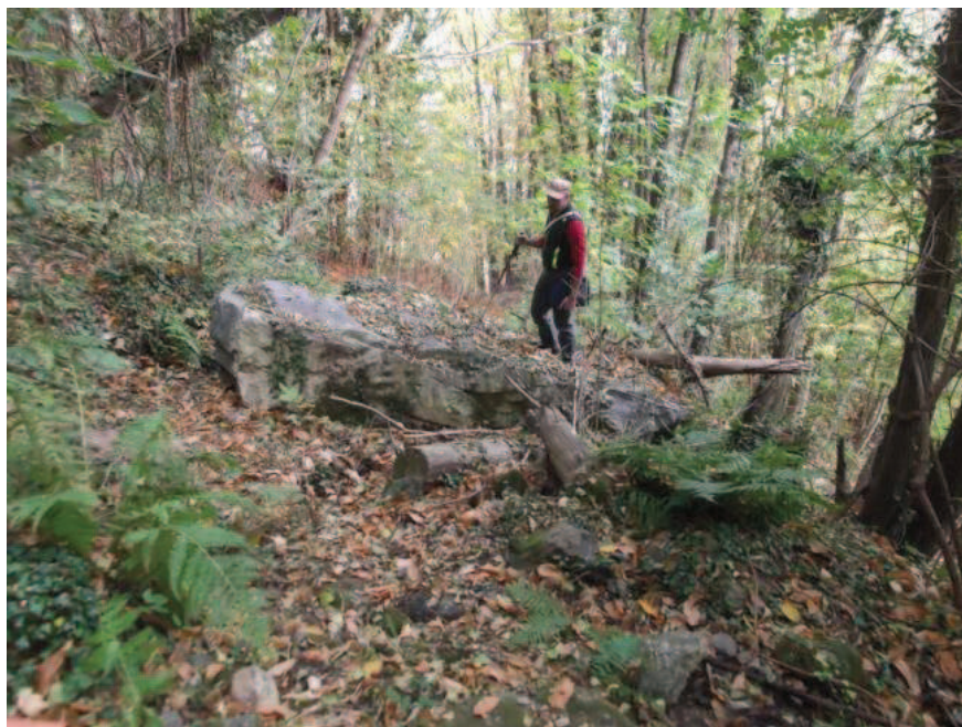
Foto 08 – Blocco 4 lastriforme di 7,2mc lungo il sentiero relativo al fenomeno di crollo avvenuto nel 2007
