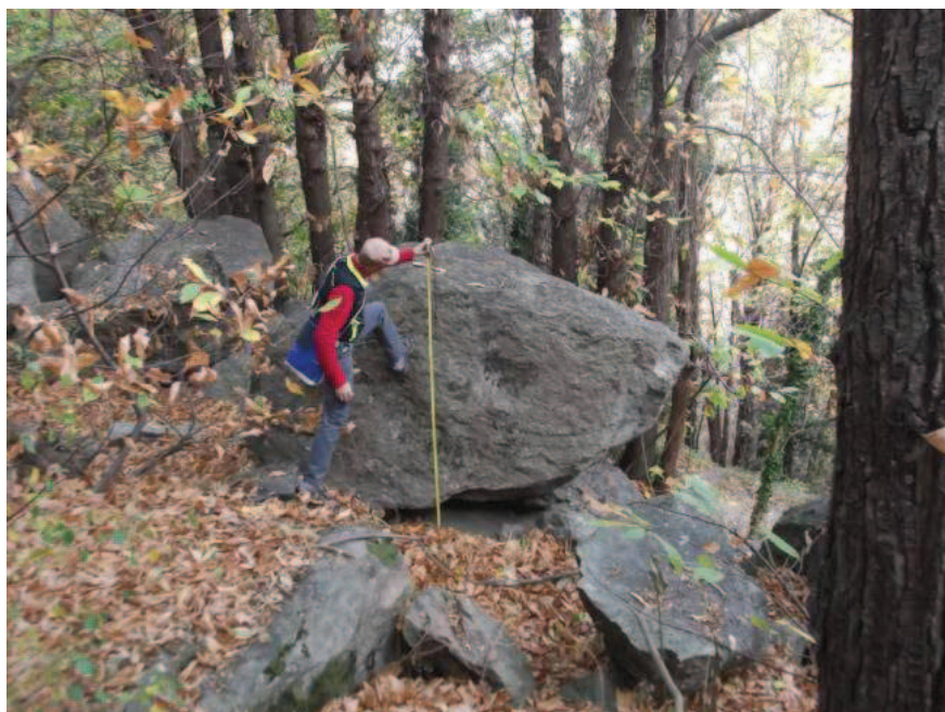
Foto 09 – Blocco 5 di ca 12mc in corrispondenza della pietraia a monte della strada poderale alla quota 500 m. Questo settore è stato interessato da fenomeni di crollo nel 2010
