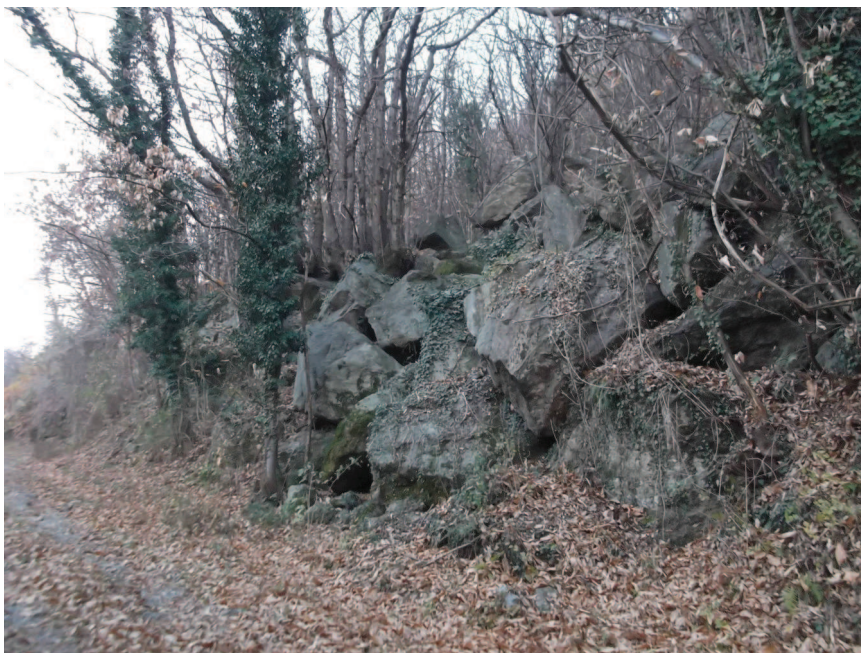
Foto 32 – Margine meridionale della falda detritica di quota 500m, dove sono presenti numerosi blocchi con volumetrie maggiori di 5mc in precarie condizioni di stabilità direttamente a monte della pista di accesso alla vasca dell'acquedotto. Vedi anche foto 9-10.
