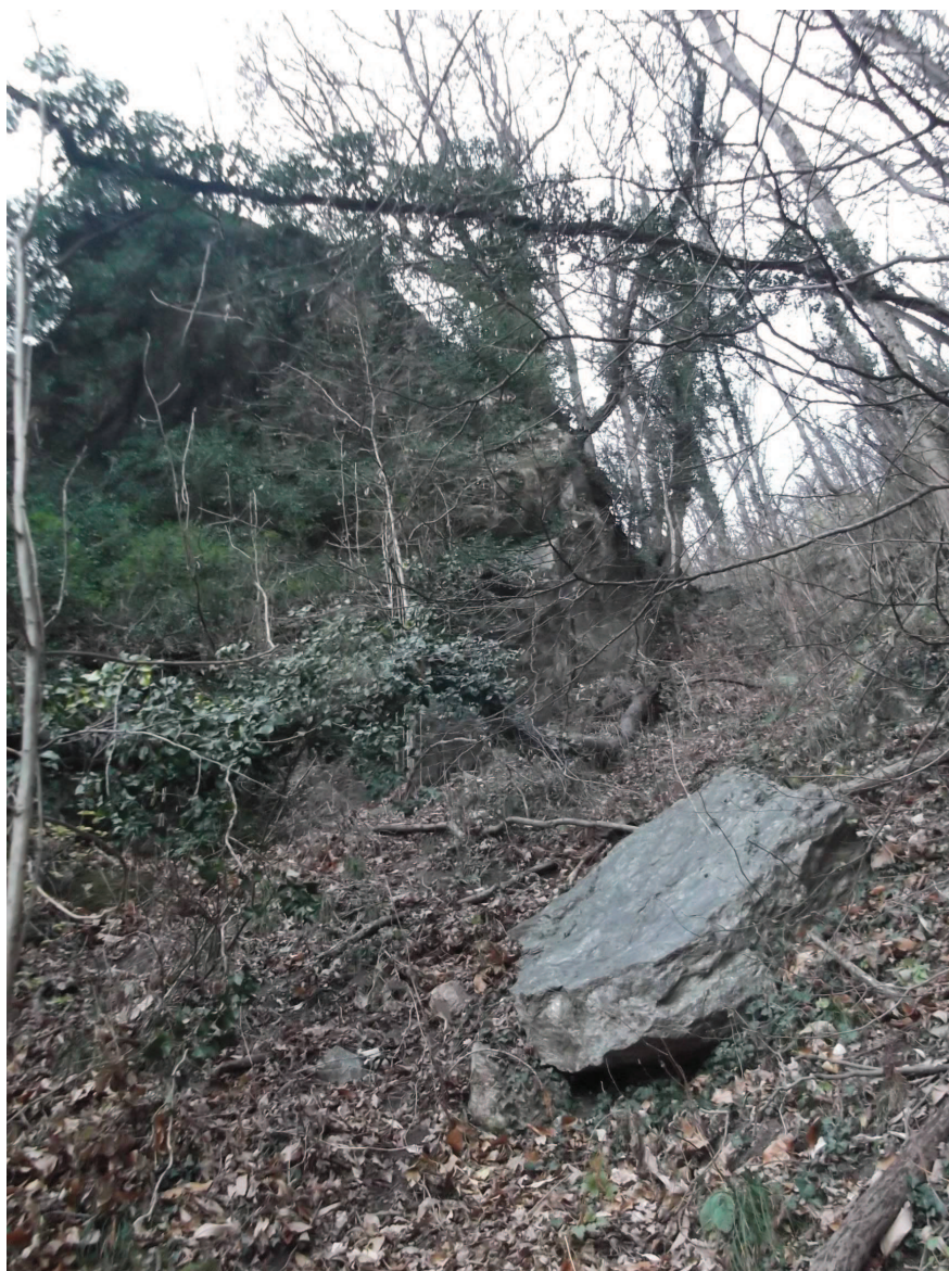
Foto 35 – Blocco 27 di ca. 1mc al piede dell'affioramento roccioso posto subito a valle della pista poderale.
