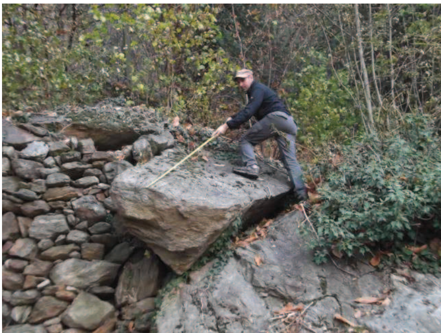
Foto 20 – Blocco 15 di 5.35mc in corrispondenza di un terrazzamento a monte delle case.
