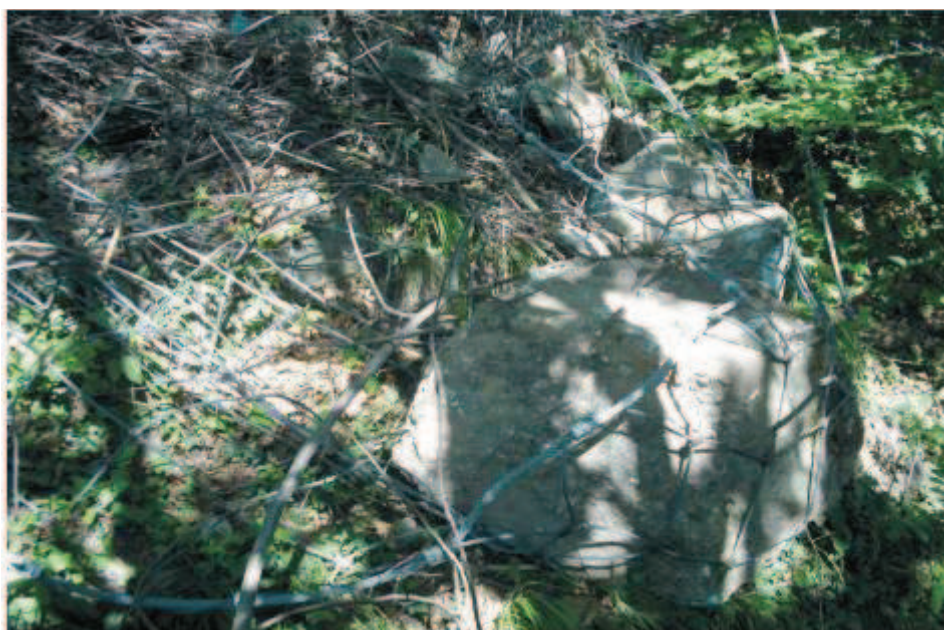
Foto 47 – Blocco D di circa 1,5-1,8mc intercettato dalla rete paramassi durante il fenomeno di crollo avvenuto nel 2011 (fotografie tratte da Bolognini). Blocco rimosso o mascherato dalla fitta vegetazione
