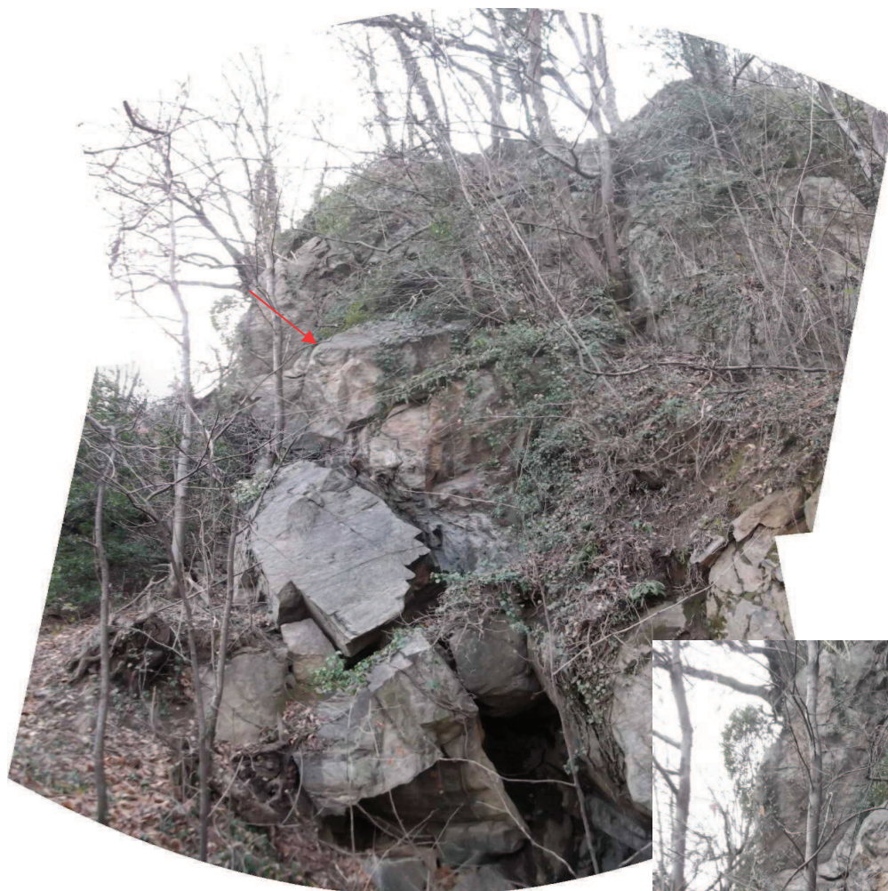
Foto 24-24 bis – Blocco 19 di 12 mc. Si tratta di comparto roccioso fratturato e disarticolato, posto alla base della balza rocciosa alla quota 360 m, attualmente incastrato e difficilmente mobilizzabile. A monte è presente un volume fessurato alla base (freccia rossa - 6 mc – blocco 19 bis) ripreso nella foto sotto.
