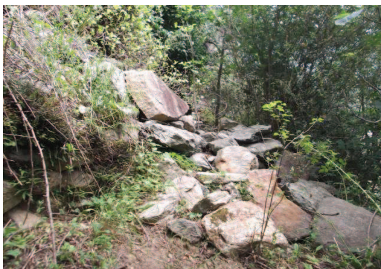
Foto 28 – Blocco 23 di 0.5mc generato dall'instabilità di muri a secco.
