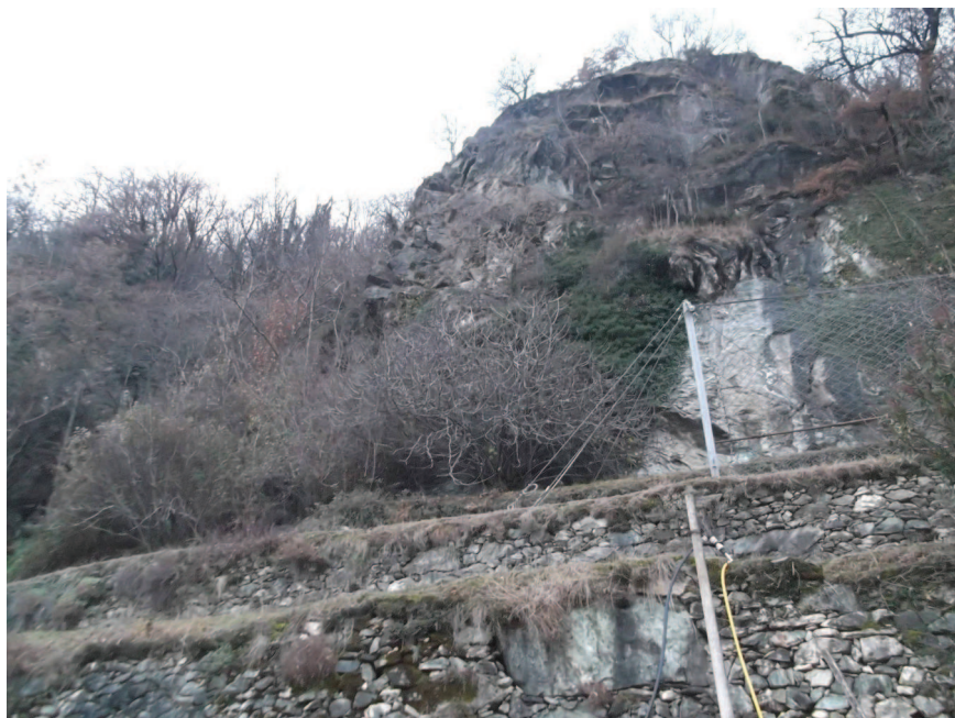
Foto 40 – Particolare del tratto strapiombante del dorso roccioso posto poco a monte del fabbricato di quota 375m, dove si evidenziano i terrazzamenti agricoli al piede della roccia e le barriere paramassi esistenti a protezione del fabbricato.
