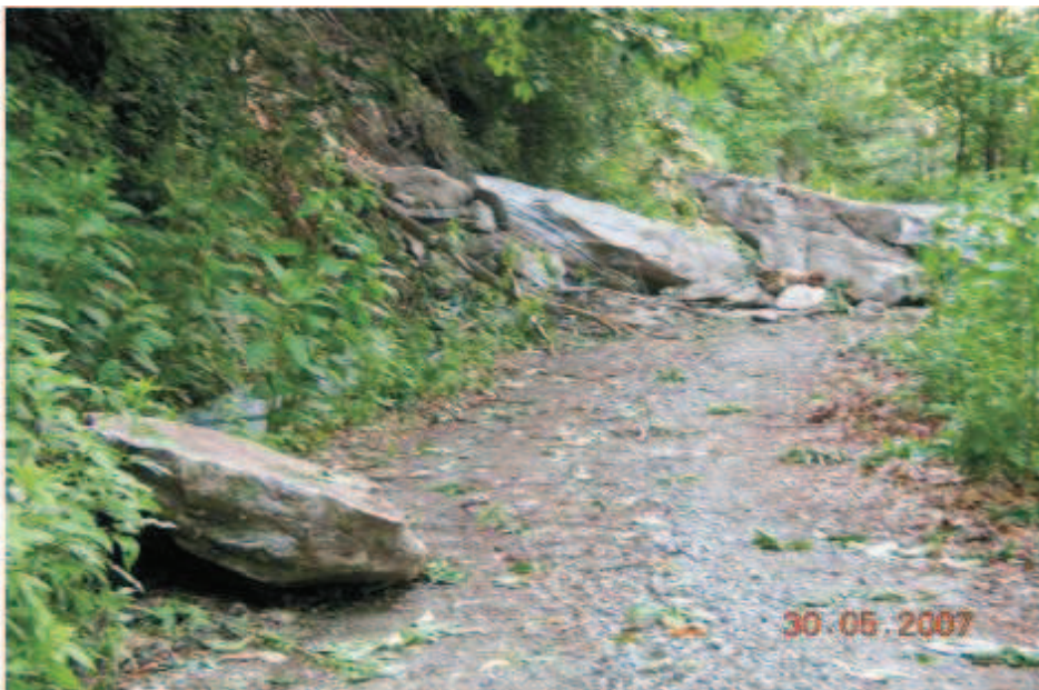
Foto 45 – Blocchi A e B (rimossi) da 0,4 a 2mc corrispondenti al dissesto avvenuto nel maggio 2007 lungo la viabilità di accesso alla vasca (fotografie tratte da Bolognini)
